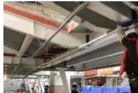
이문고가하부 : 관수/급배수 공사
