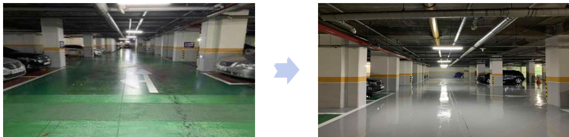
[건축물 부설주차장 개방 공사 전·후 사례]
