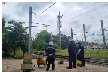
작업 전 TBM 확행
