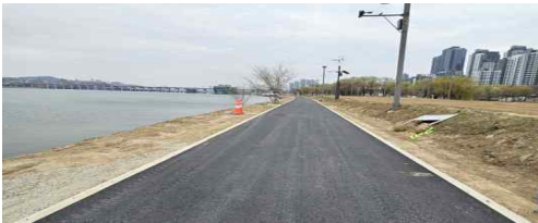
<비포장도로 평탄화 및 포장(서래섬)>
