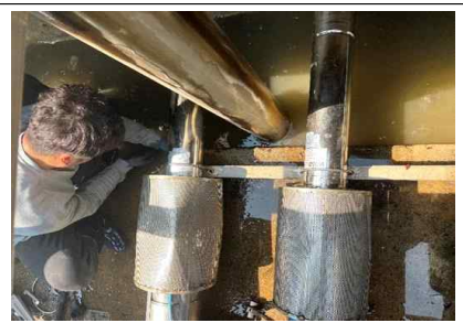
<여의도 물빛광장 펌프 점검>
