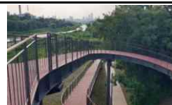
《하천 접근로 설치》
