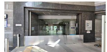
[연결통로 차수판 설치]
