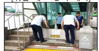
[폭우 대비 차수판 설치]
