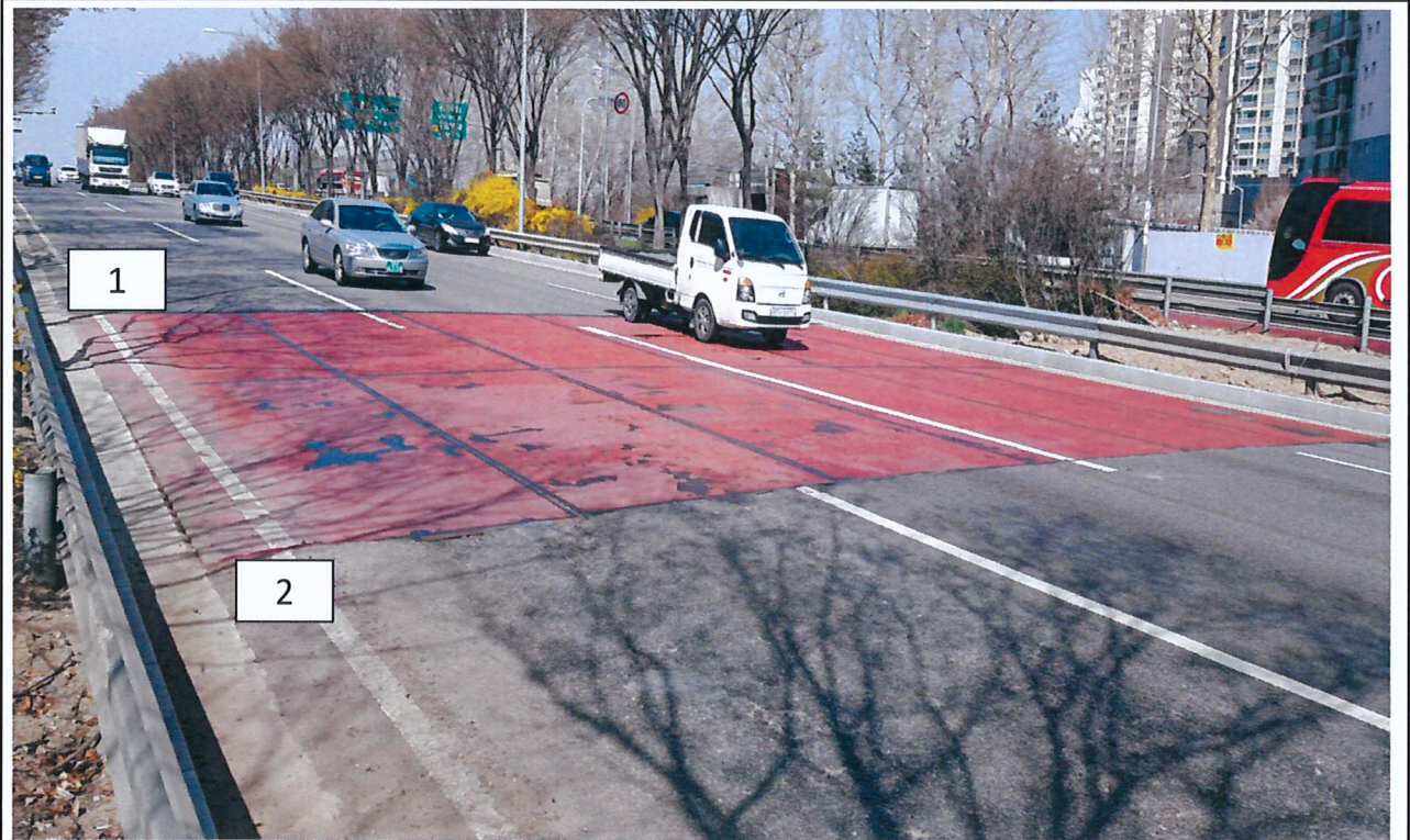
위 치 올림픽대로 김포방향 내 용 침하방지 철판 전경
