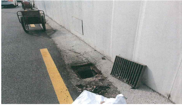
조치전(Pumping 지점 배수로 준설)
