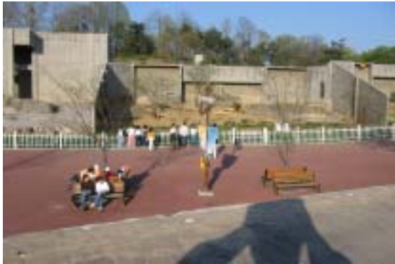
안전관리 강화(人止壕 설치)
