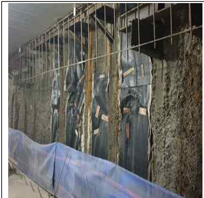
벽체 배수판 설치
