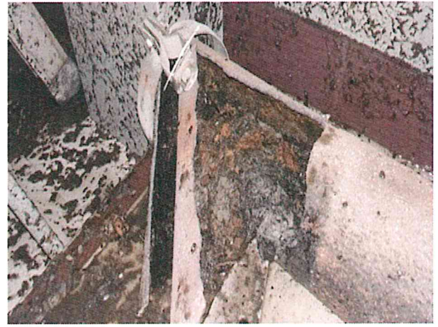
공사 전(막힌 오수관-주철)
