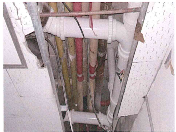
공사 완료(오수관 교체)
