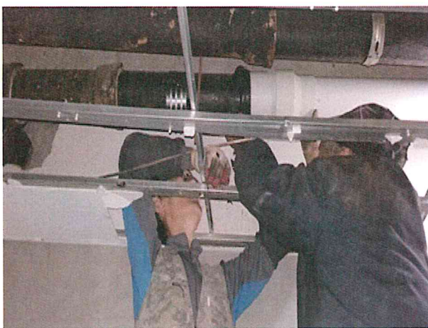
공사 중(PVC 배관 )
