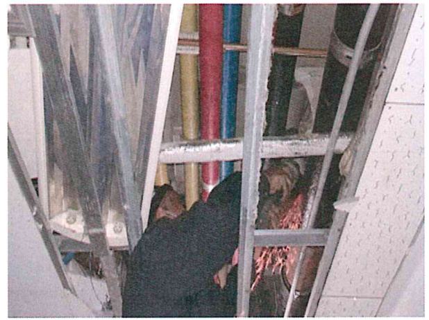
공사 중(주철 배관 철거)
