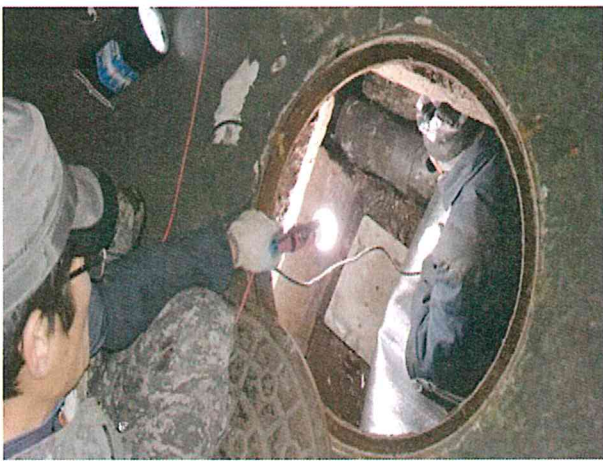
공사 전(정화조 배관 확인)
