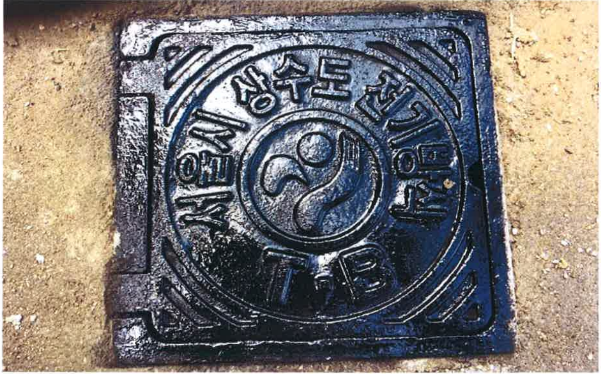
5. 2번 측정함(TEST BOX) 설치사진
