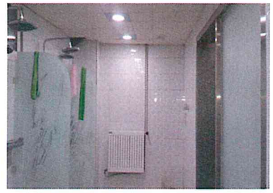
샤워장 방열기 설치(후)
