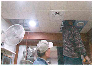
샤워장 방열기 설치(전)
