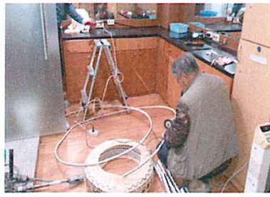
샤워장 방열기 설치(중)
