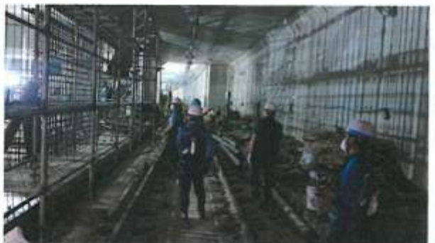
현장 점검 사진
