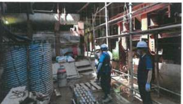
현장 점검 사진
