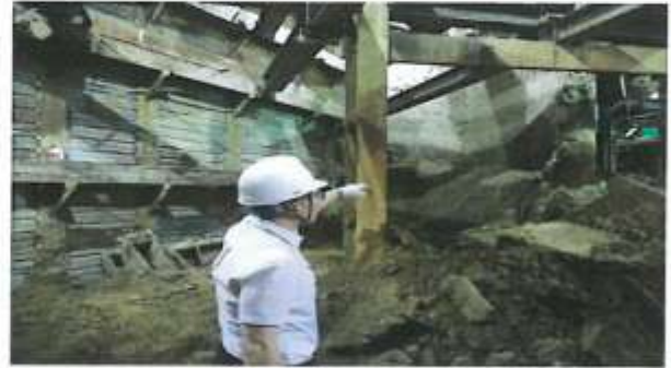
현장 점검 사진
