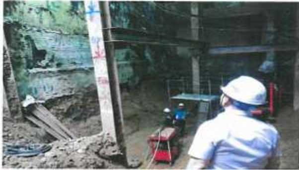
현장 점검 사진
