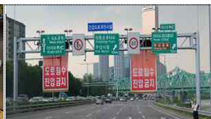
긴급 도로차단 시설
