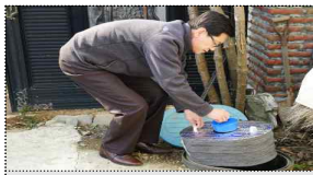
〈한파대책〉 상수도 보온재 설치
