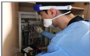
〈생활실 내 전기설비 보수〉
