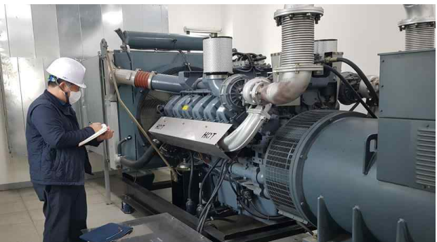
〈송파구 위례중앙지하차도 배수펌프 점검〉
