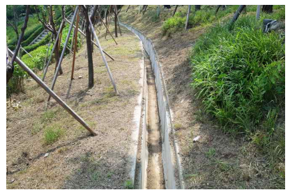
〈 배수로 준설 상태 확인 〉
