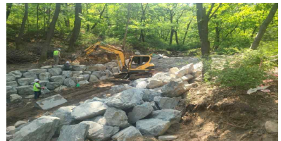
〈공사 중(계류보전, 도봉)〉
