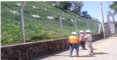
〈공사 완료(위험절개지, 종로)〉
