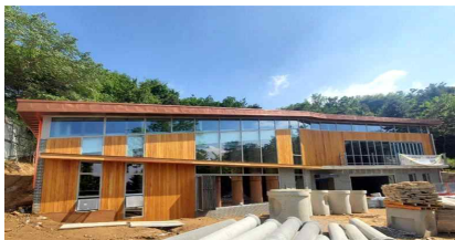
<광진>아차산 책쉼터 공사 중 전경>
