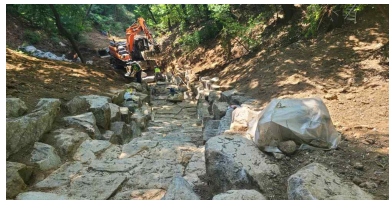
〈공사 중(계류보전, 강남)〉
