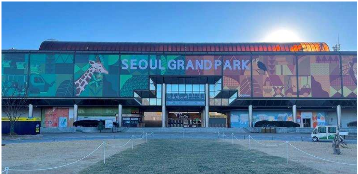
〈서울대공원 종합안내소 관람환경 개선 사업 준공현황(사진)〉
