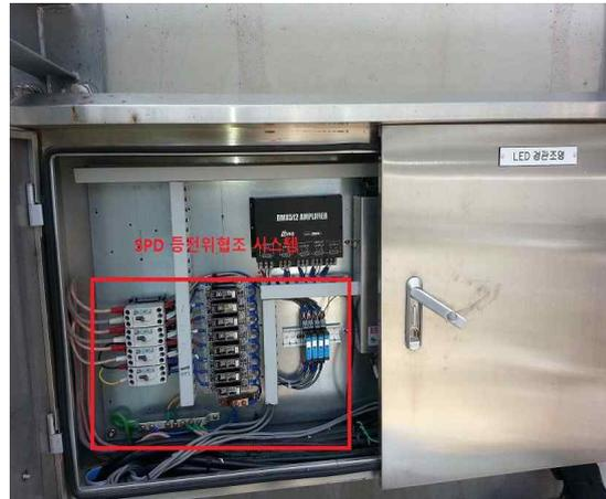
그림.1 SPD등전위공사 설치 도면 (①배선용차단기 ②SPD)
