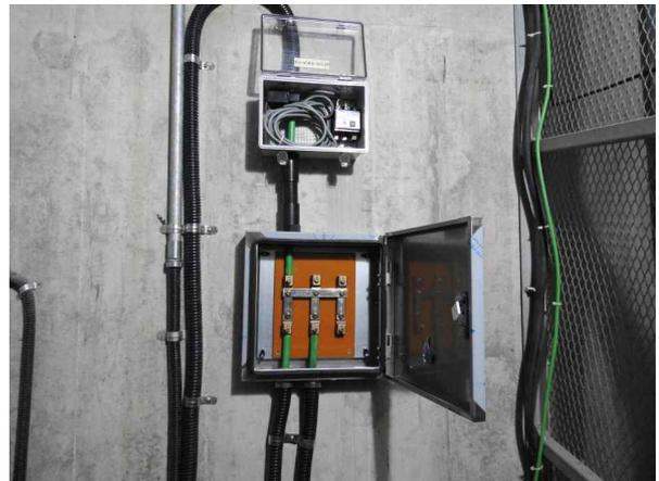
그림.3 뇌격계수기 설치도면 및 설치사례
