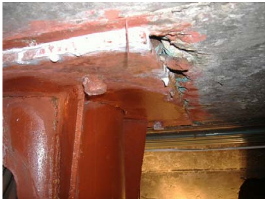
사진11 볼트체결불량, 용접누락, 들뜸 및 채움부족, 누수
