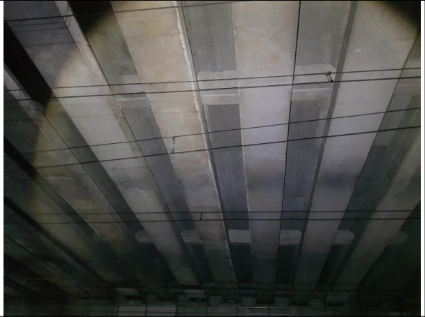
거더 및 가로보 전경
