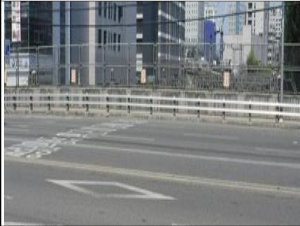
난간 및 연석 전경(차도부)
