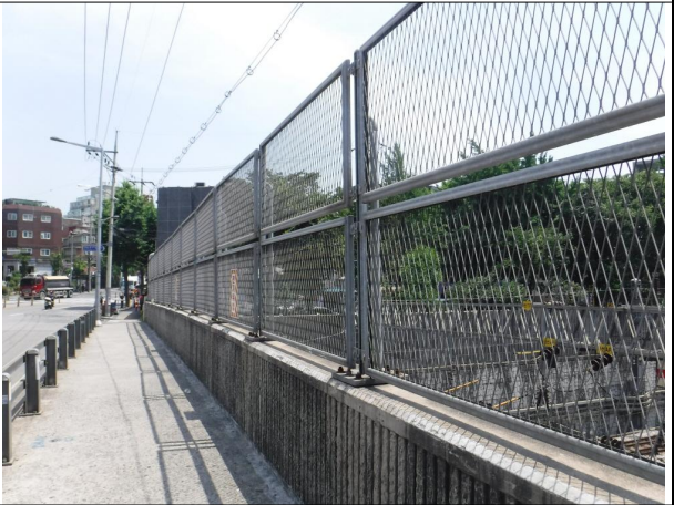
난간 및 연석 전경(보도부)
