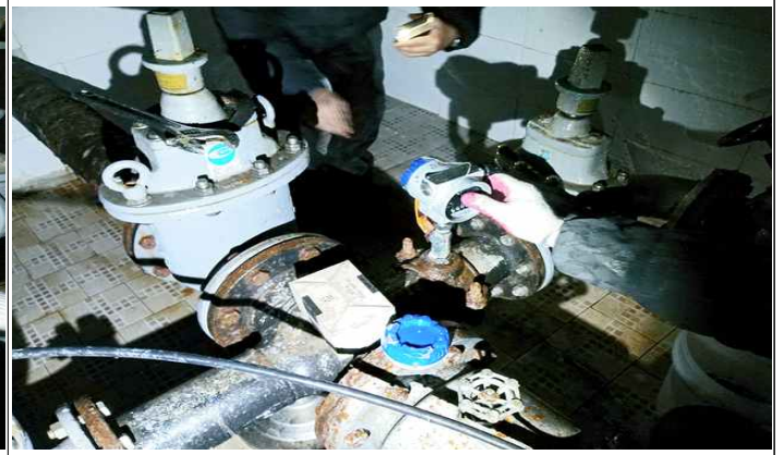
취경B증압장 토출압력 배관 동결로 PID운전 이상 정비(해빙 및 천공)완료(12.31.)
