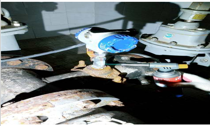
취경B증압장 토출압력 배관 동결로 PID운전 이상 정비(해빙 및 천공)완료(12.31.)
