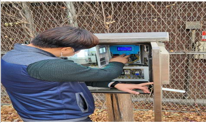
용마배수지 1지 초음파수위계 헌팅 정비(감도조절 및 전원접지 연결)완료(12.20.)
