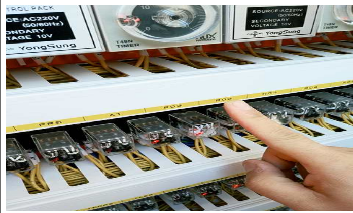
취경B증압장 R03 릴레이 불량 펌프2호기 운전이상 임시정비(릴레이 임시교체)완료(12.31.)
