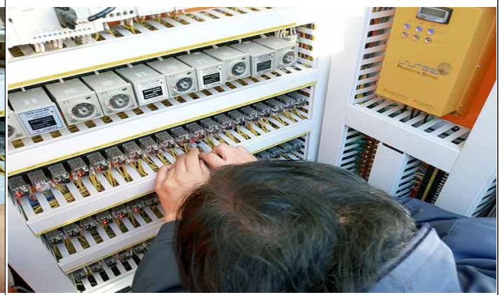
취경B증압장 R03 릴레이 불량 펌프2호기 운전이상 임시정비(릴레이 임시교체)완료(12.31.)
