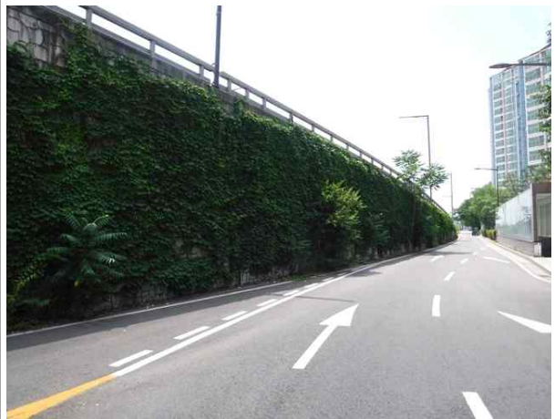
접속옹벽 전경(시점 우측)
