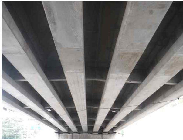
거더 및 가로보 전경
