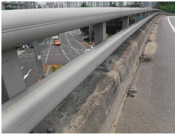
난간 및 연석 전경
