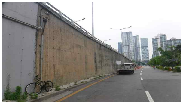
접속옹벽 전경(시점 우측)
