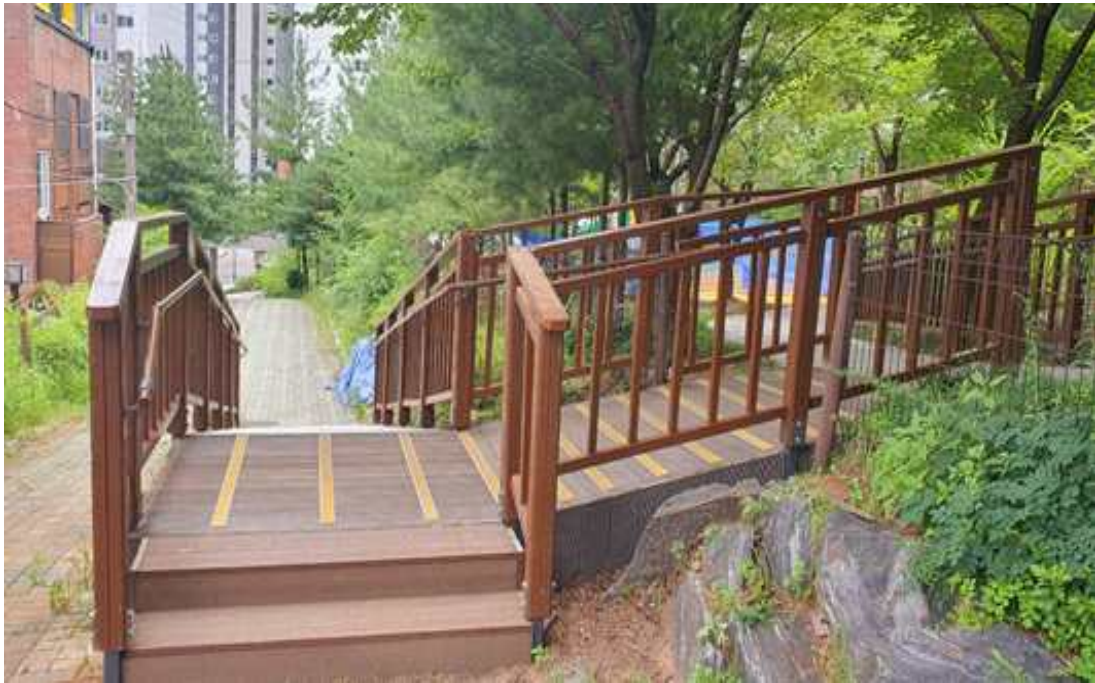
공사 후(안전휀스, 핸들레일)
