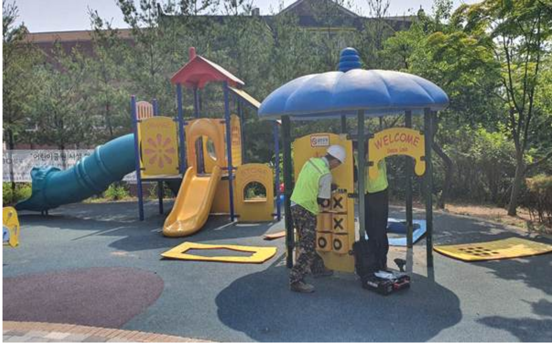
공사 전(고무칩, 놀이시설)
