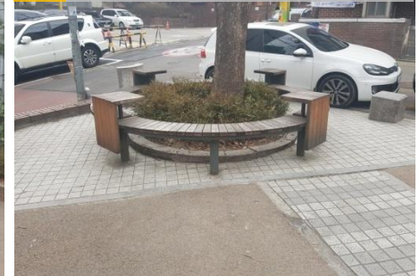
라 관목제거 및 수목보호벤치 철거
