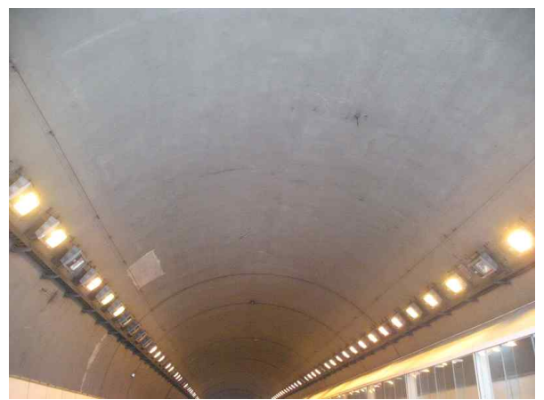
라이닝 천단부 전경
