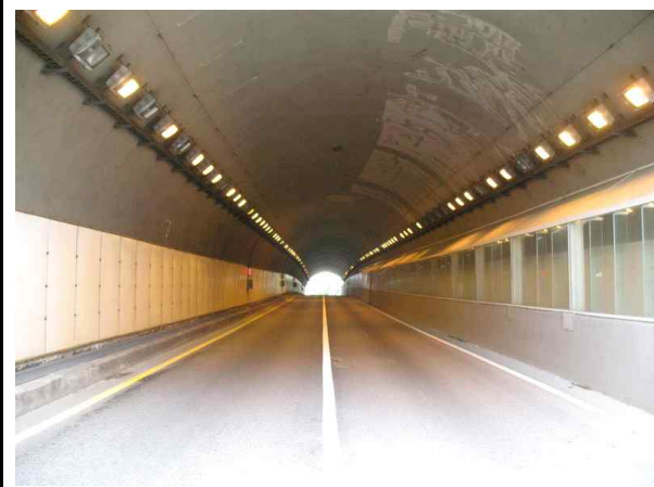
터널 내부 전경
