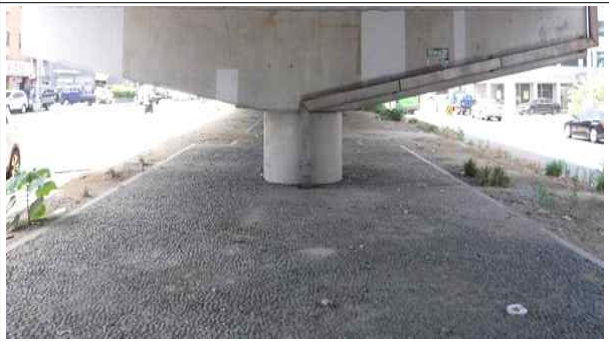
교각 지중 매입 전경
