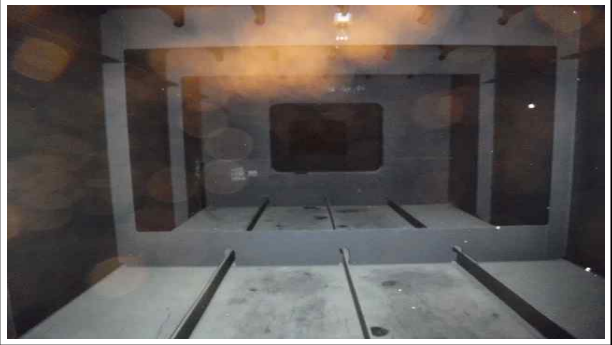
거더 내부 전경
