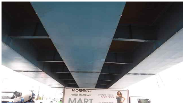
거더 외부 전경
