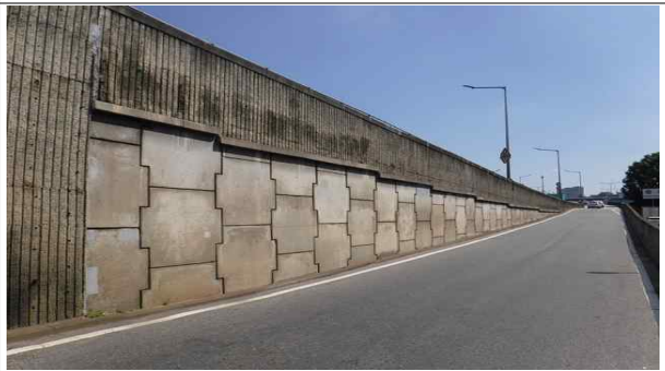
접속옹벽 전경(시점 우측)
