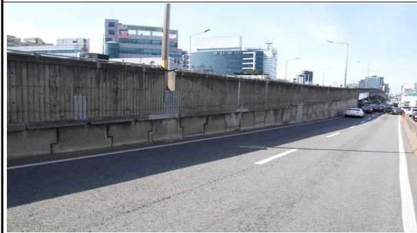
접속옹벽 전경(시점 좌측)
