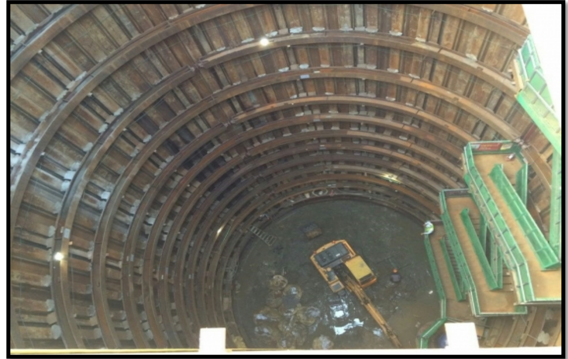
<머니투데이. 2016.10.28. "'초등학교 앞 매연 환기구라니'...서울시 지하도로 사업 '갈등' 서울시 제물포터널 사업의 양평유수지 내 환풍구 공사현장 사진>
