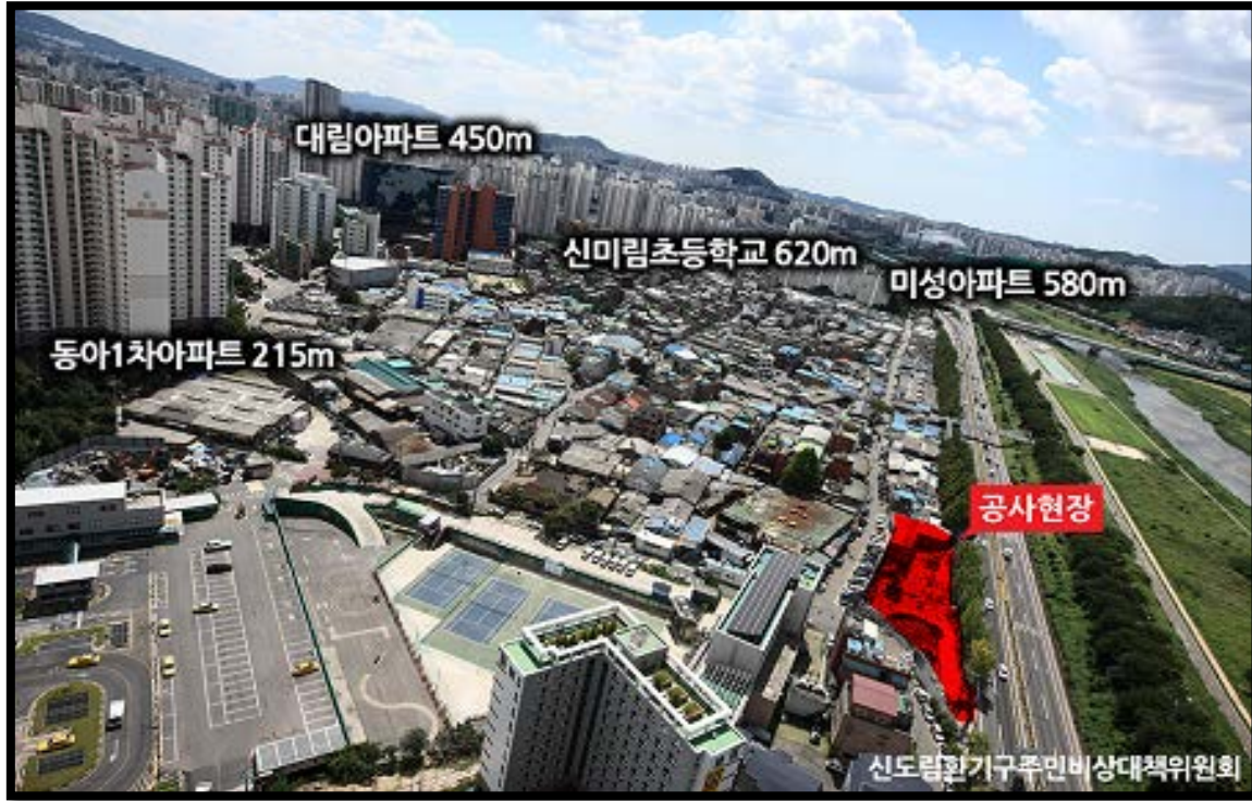
<일요서울. 2016.11.18. 서울시 서부지하도로 사업 갈등...의원 폭행 사건까지 도로 뚫으려다 짝 막혔다. 서울 구로구 신도림동 환기구 공사 주변 일대 모습>
