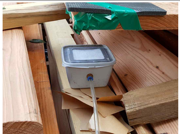
약제받침 및 투약호스 설치
