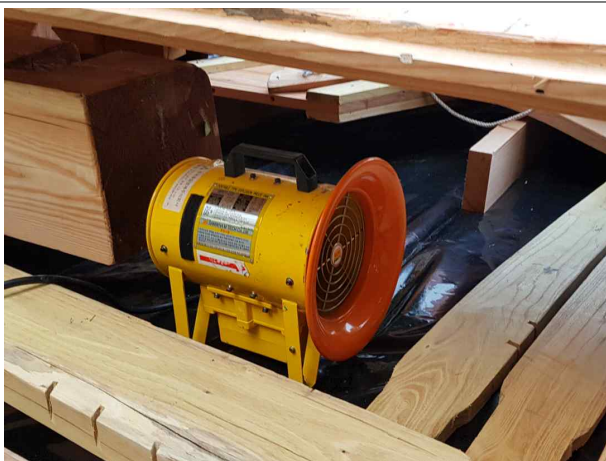
가스균일화를 위한 교반용 방폭형팬 설치
