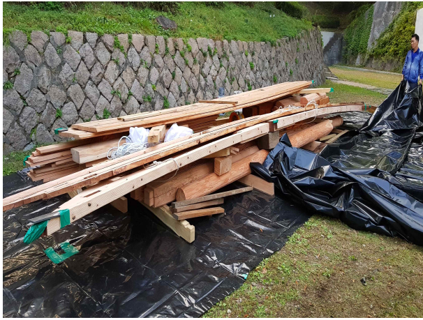
바닥비닐 설치 후 피훈증물 적재
