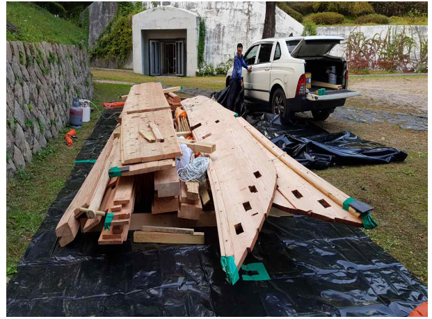
바닥비닐 설치 후 피훈증물 적재
