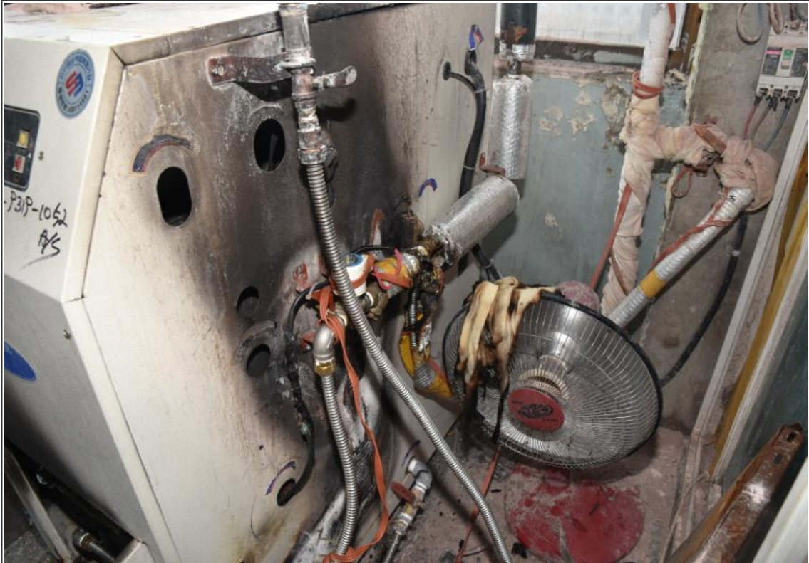
사진 7 스팀 보일러 우측 외부 촬영날짜 ○ 내부 화염에 의해 외함 일부와 주변 집기류가 연소된 모습 2019.05.07.
