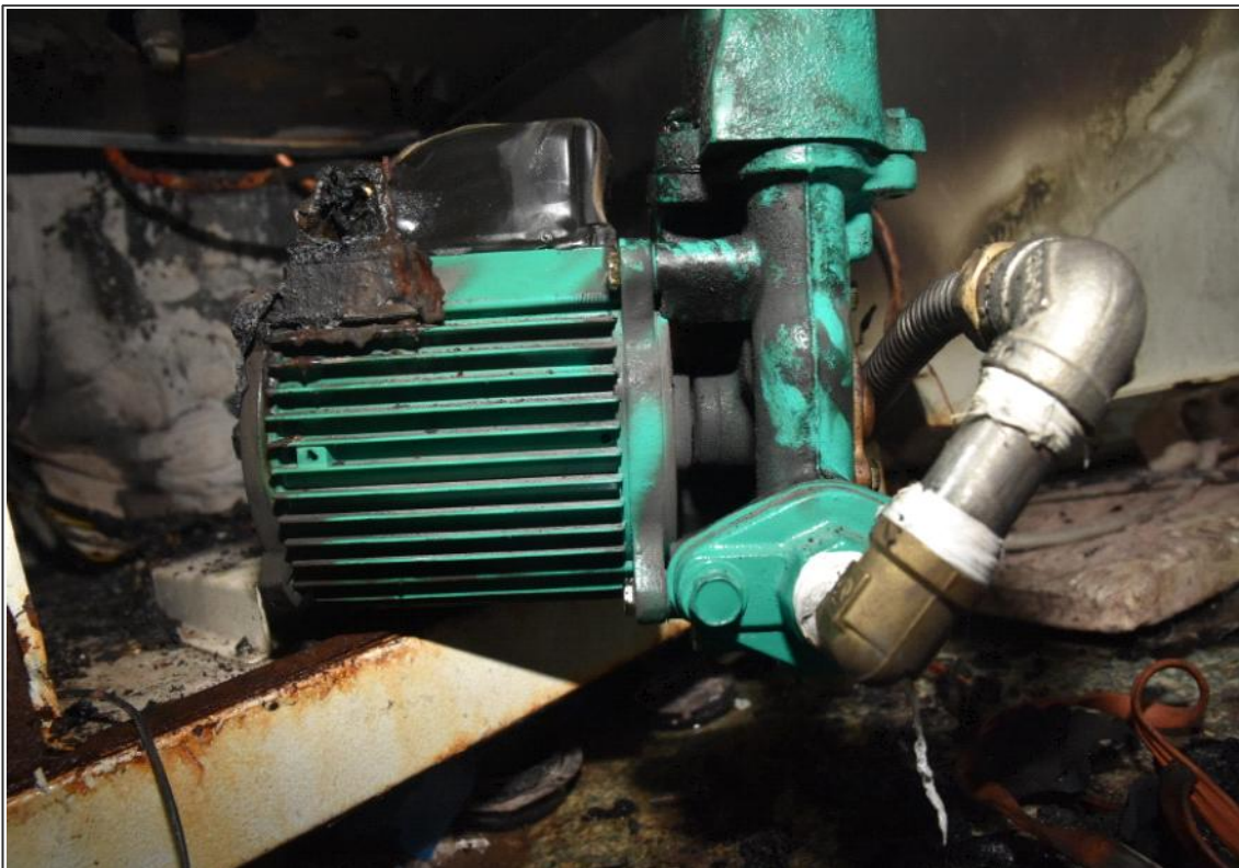
사진 14 급수펌프 좌측면 촬영날짜 ○ 연소 특이점 식별되지 않음 2019.05.07.
