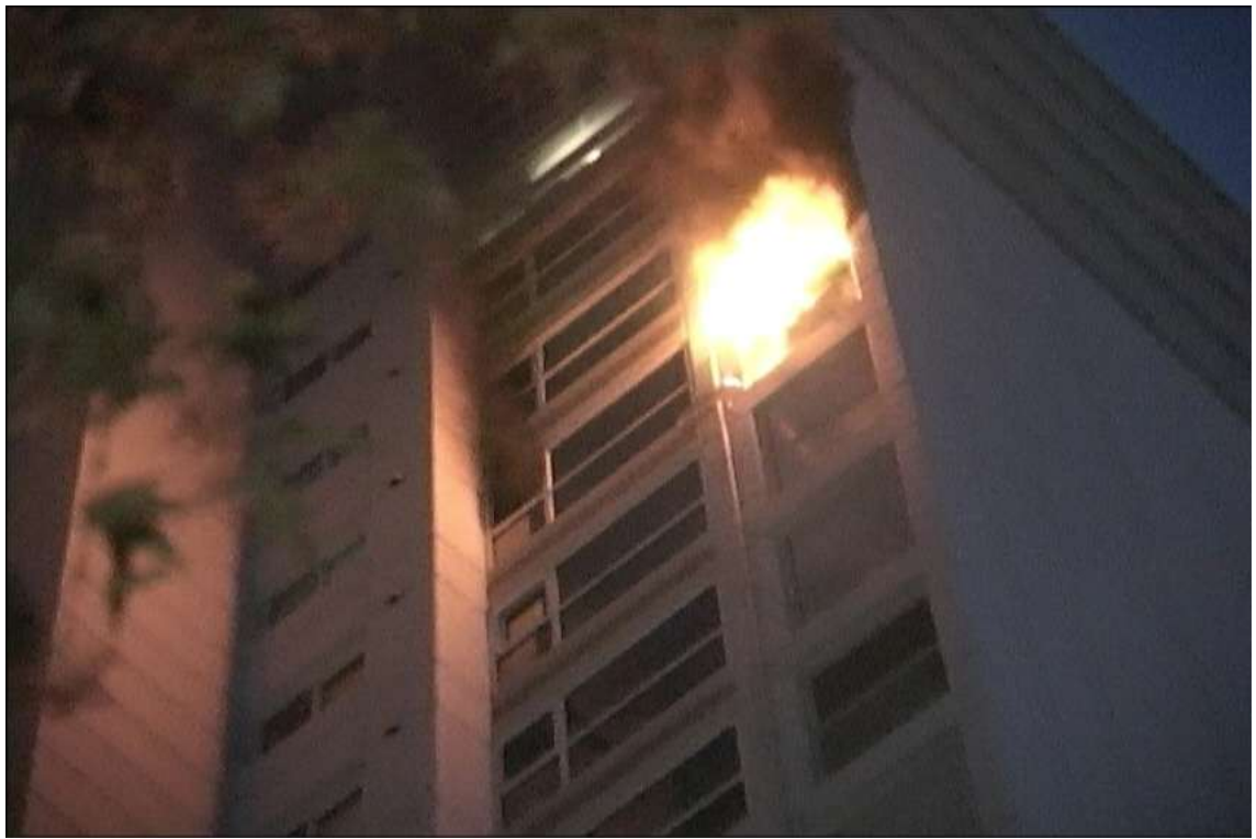
사진 1 화재발생 건물 및 초기 연소 상황 촬영날짜 ○ 다용도실 창문을 통해 상층으로 확산되는 초기 연소 상황 '11. 10. 26.
