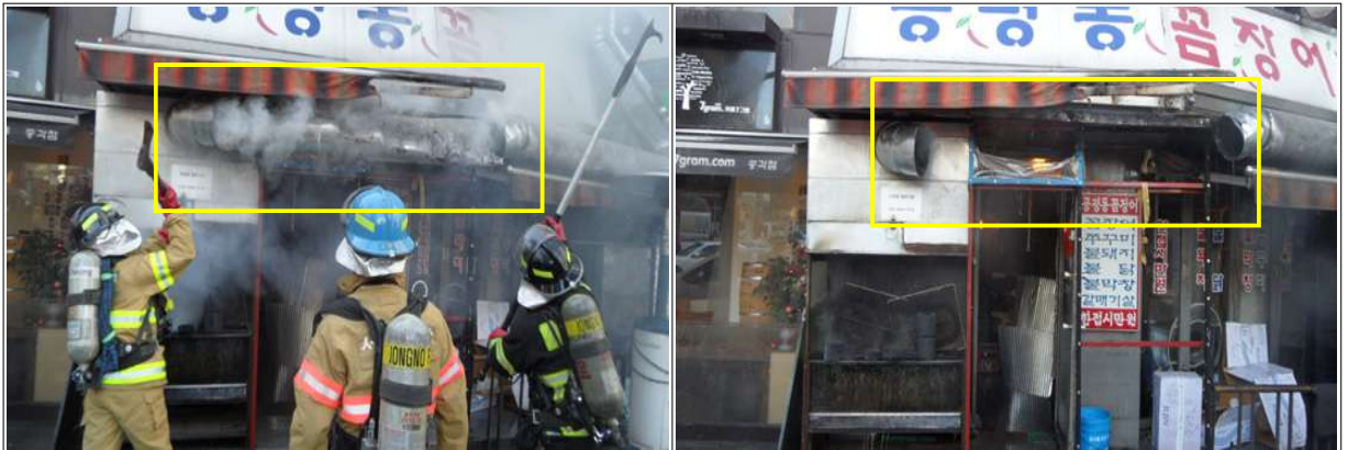
환기덕트의 연소 및 파괴상황 파괴 후 상황
