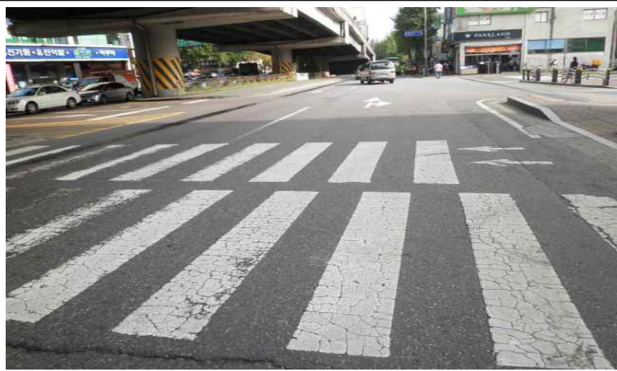
홍제2교 상부 전경
