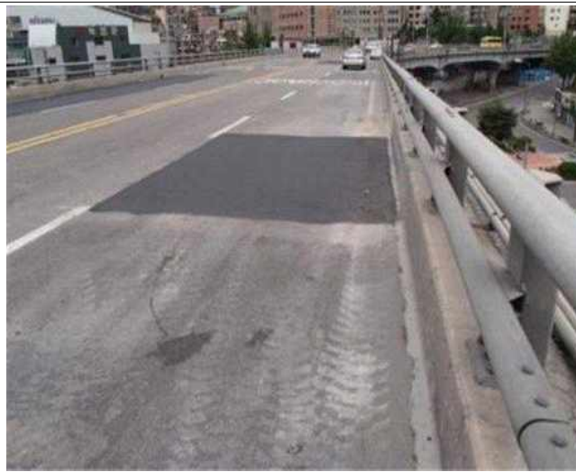
포장 보수(바닥판 치환보수)
