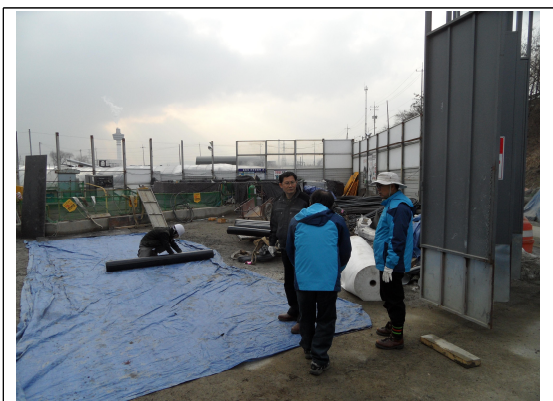
〈토평교 한전전력구 공사현장〉
