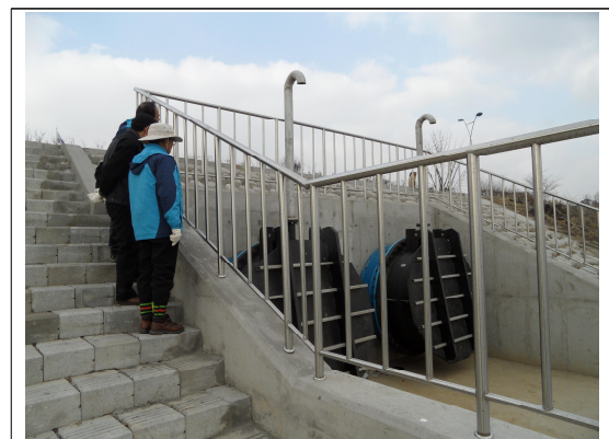
〈구리시 아천빗물펌프장 방류관공사 현장〉
