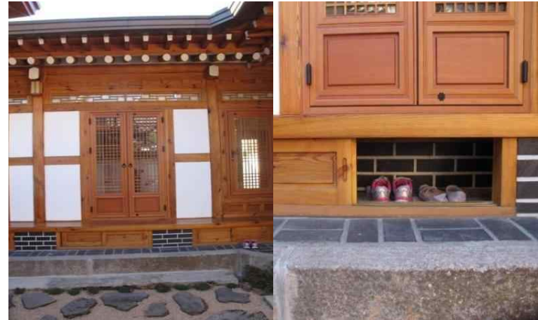
단차를 이용한 신발장 설치
