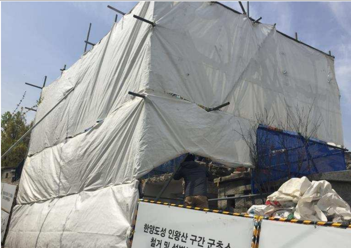
가설 및 가림막 설치
