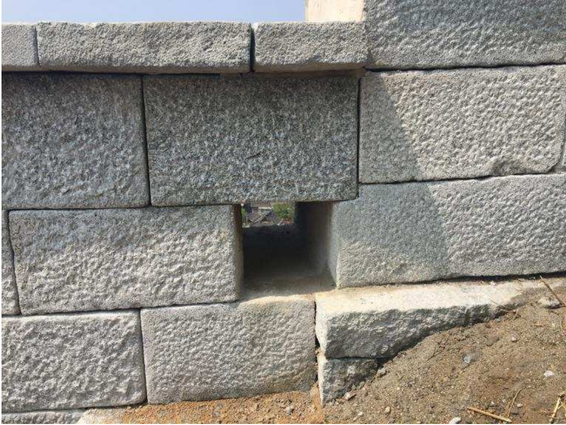
51T 여장 설치
