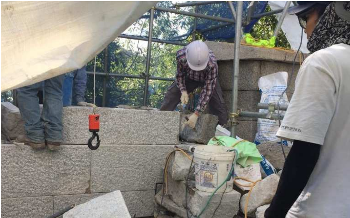
여장 귀면석 설치
