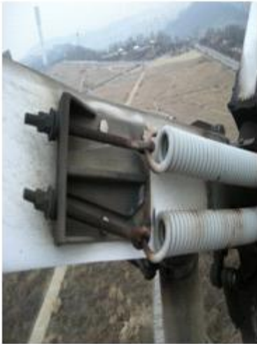
Blade Springs 고정틀 마모 상태
