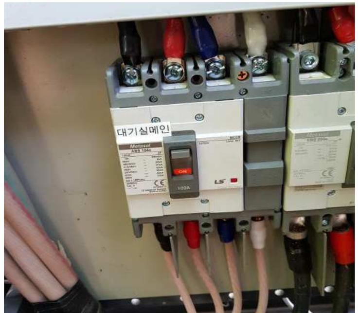
대기실 메인차단기 설치 및 간선 포설전 사진
