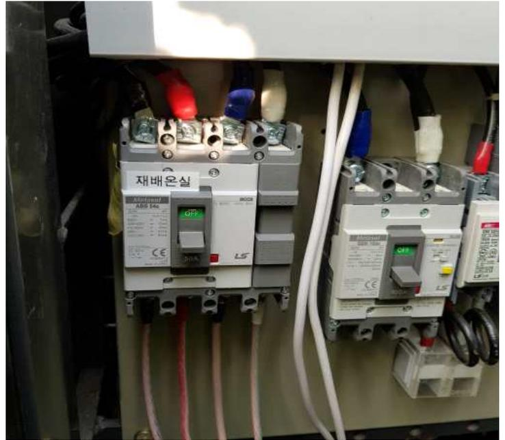
재배온실 메인차단기 설치 및 간선 포설전 사진
