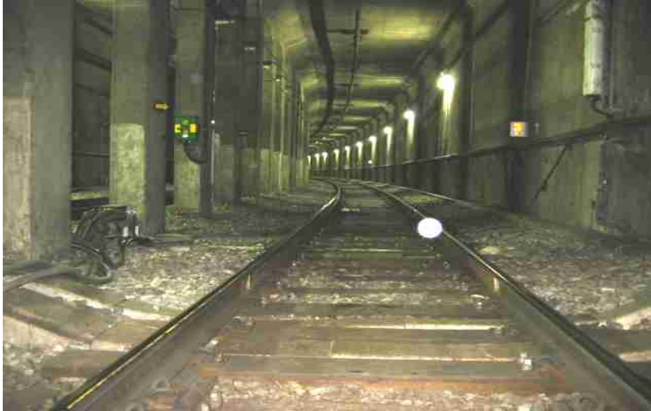
도상 콘크리트 타설 전 자갈도상
