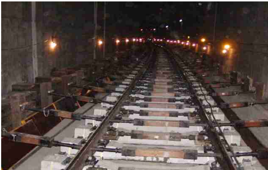
가 받침 설치 완료 상태
