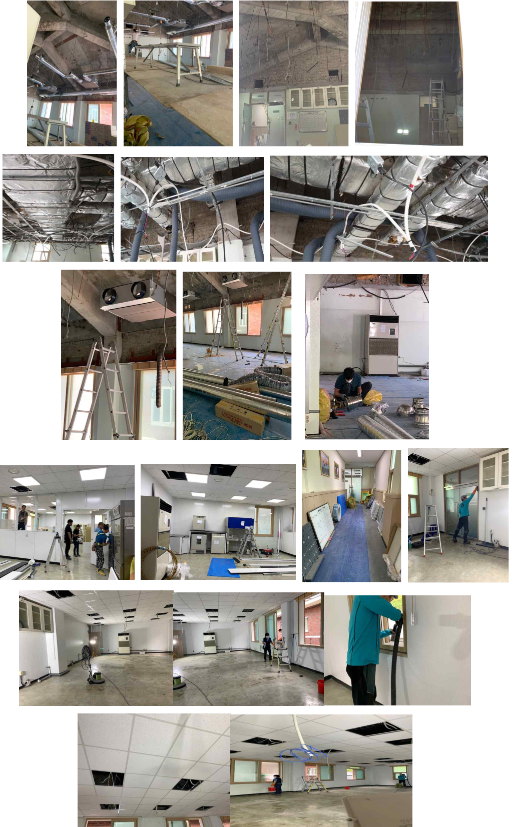
기존 유전자 실험실 천장 및 배관, 전기, 수도 등 전체 철거공사
