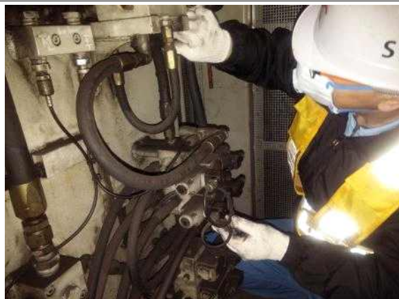
유압라인(누유 등) 상태 점검
