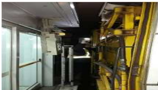
승강장 건축한계 점검(노반부)
