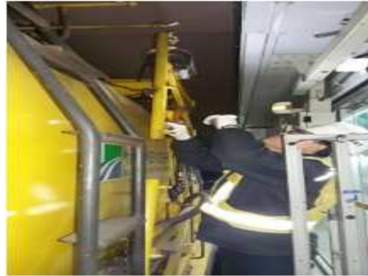
승강장 건축한계 점검(상부)
