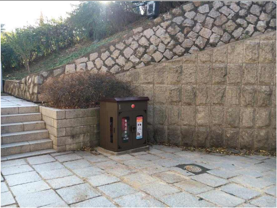
창의문 전면 소화전함 설치완료 모습
