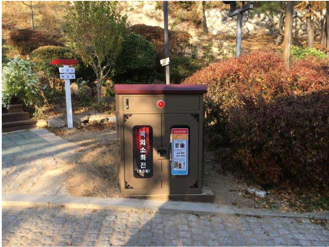
창의문 배면 소화전함 설치 완료 모습
