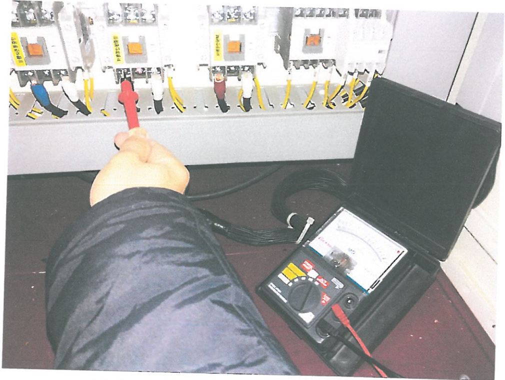
절연저항 측정 및 점검(동일로지하차도)
