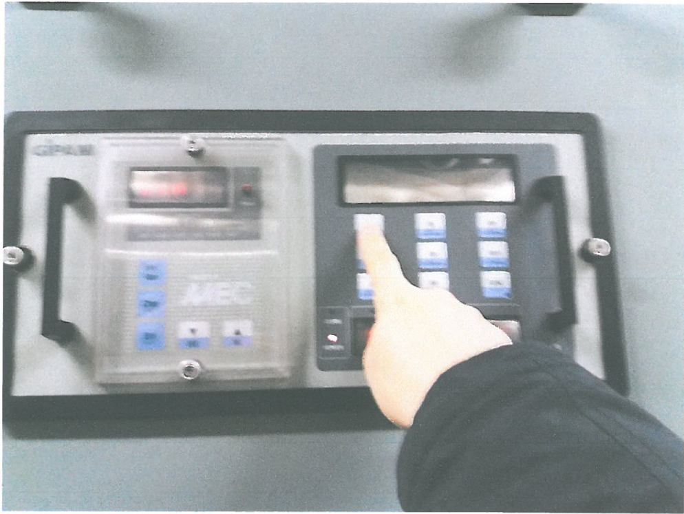
배전반 전압,전류 측정 및 점검(무지개터널)
