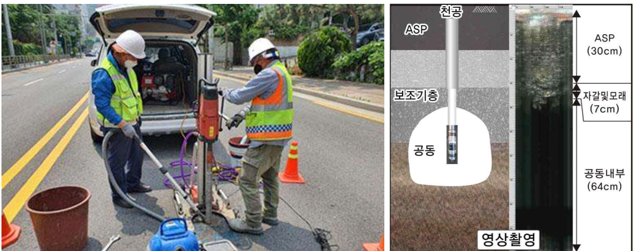
[그림 3.7] 공동예상지점 천공 전경(좌) 및 공내영상촬영 모식도(우)(예시)
