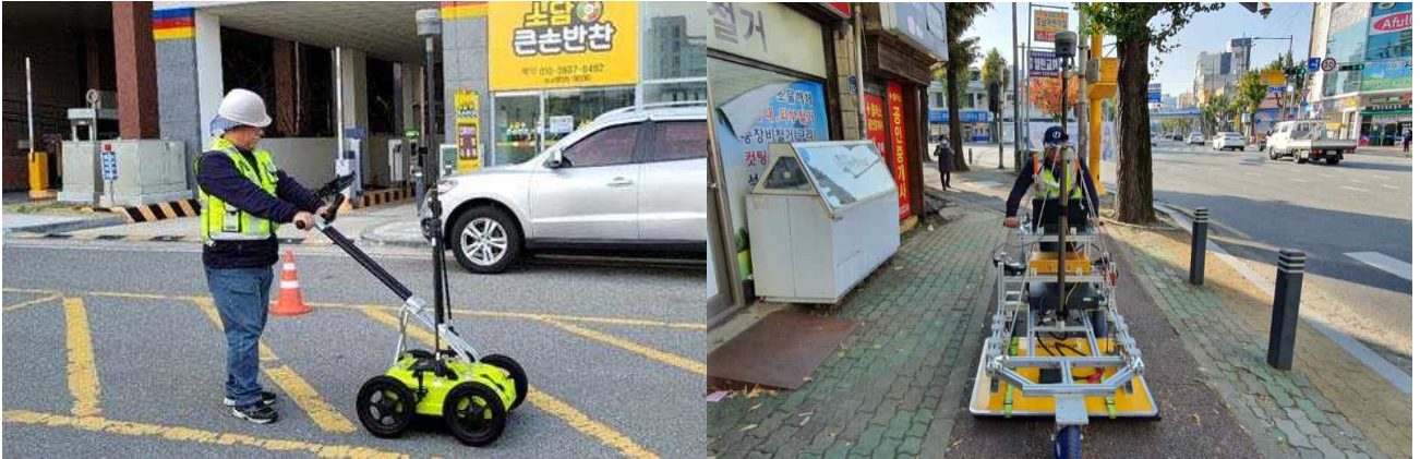
[그림 3.4] 핸디형 지표투과레이더(GPR) 탐사장비(예시)
