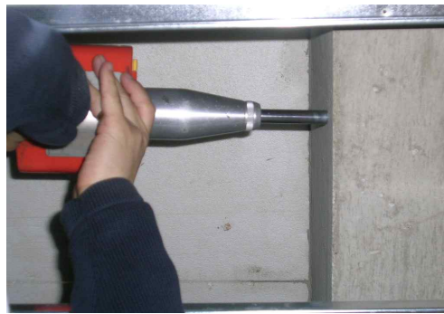
콘크리트 압축강도 조사
