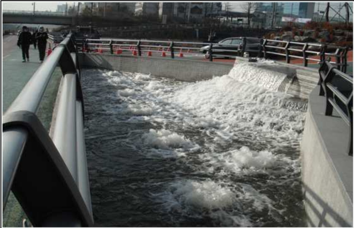
내 용 분수대 전경
