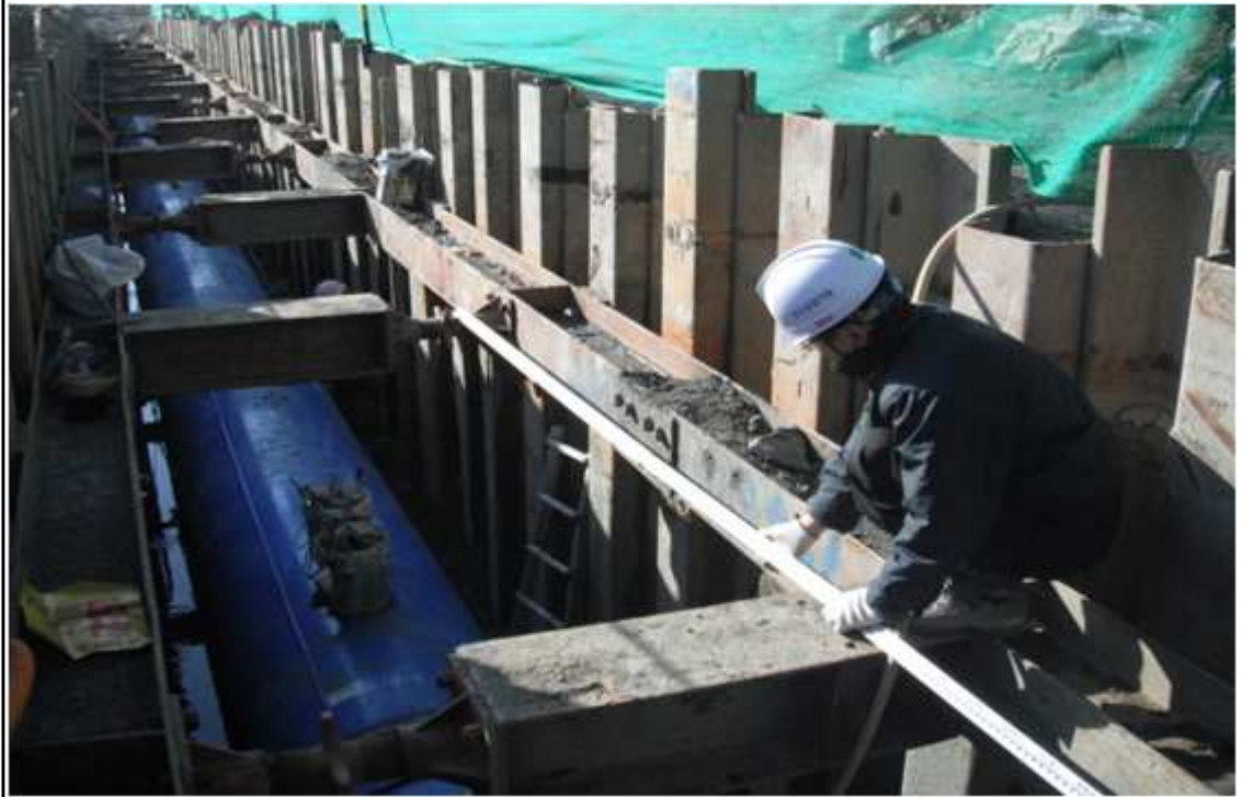
내 용 2 공구 관로부설공사 전경
