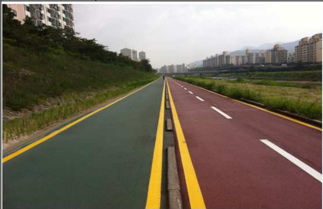
내 용 2 공구 자전거 도로 복구 전경
