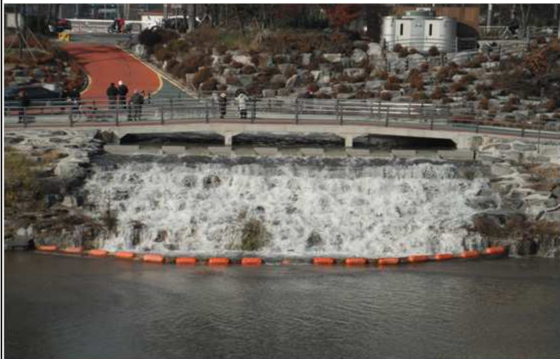
내 용 분수대 방류 전경
