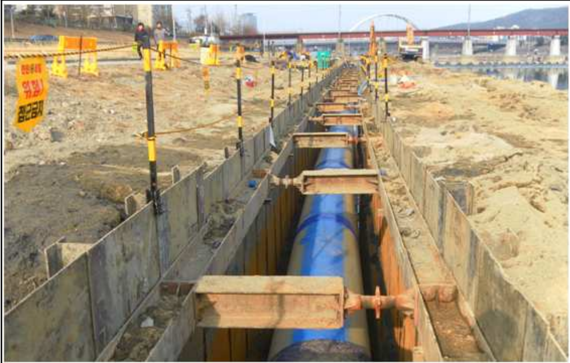
내 용 1 공구 관로부설공사 전경
