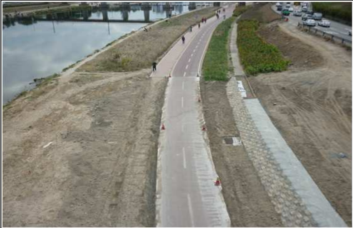
내 용 1 공구 공사 착공전 사진
