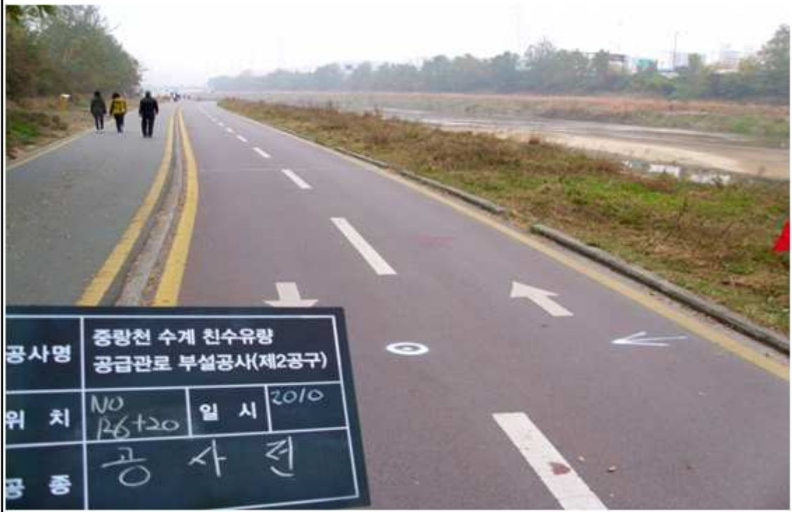
내 용 2 공구 공사 착공전 사진
