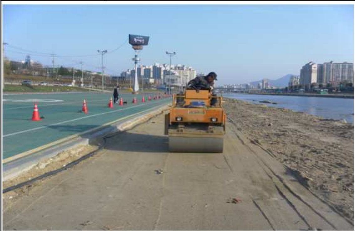
내 용 관로부설 후 전경
