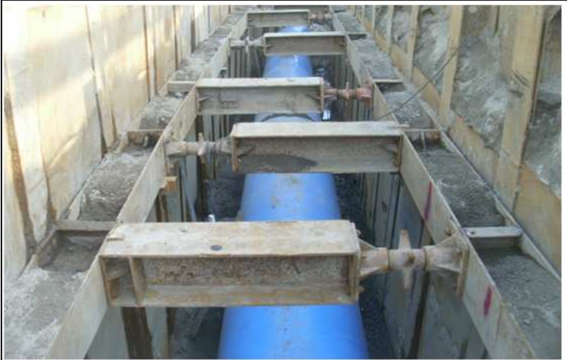
내 용 관로부설공사 전경
